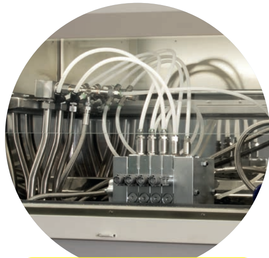
Estrazione tramite pressure rinse e internal rinse
